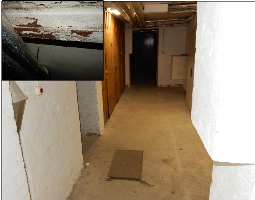
Balk med ytrost samt bild på källargång
