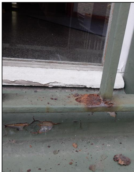
Början till fuktskador samt rostskador fönsterpartier med fransk balkong
