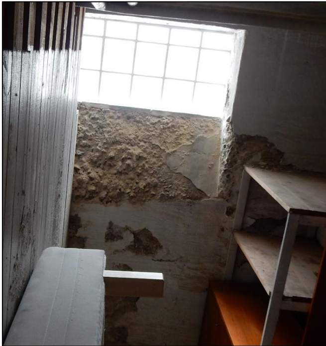
Källaryttvägg mot gata med putssläpp
