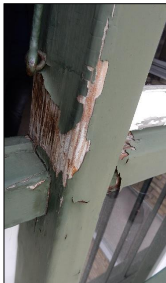
Början till fuktskador samt rostskador fönsterpartier med fransk balkong
